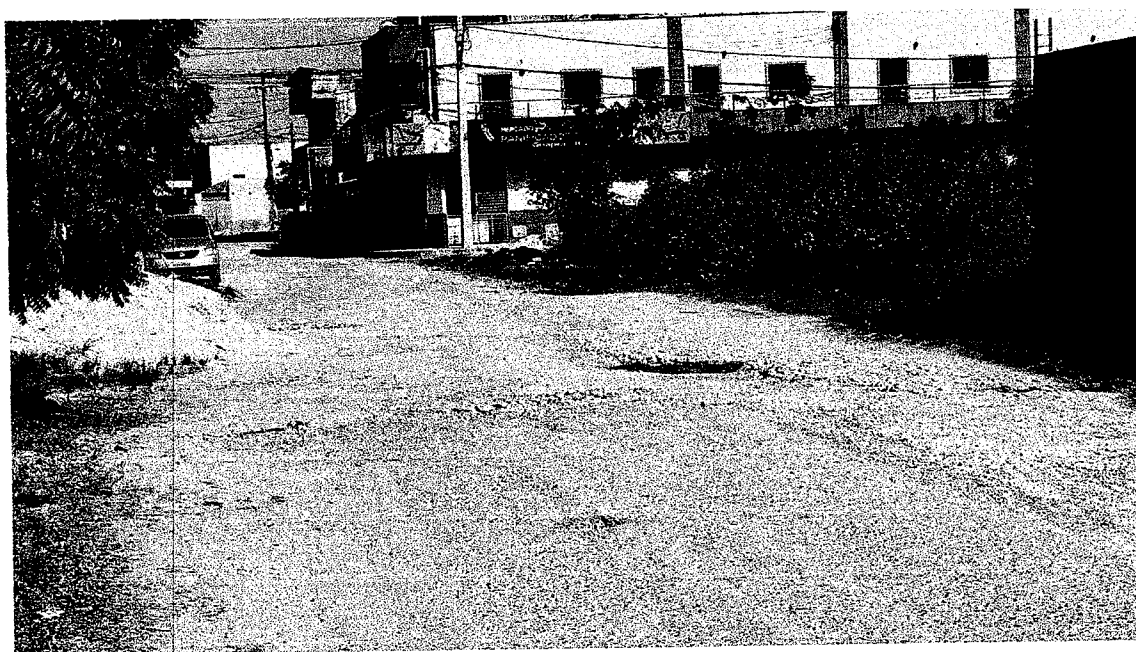
FIGURA 02: RECOMPOSIÇÃO DA PAVIMENTAÇÃO ASFÁLTICA
