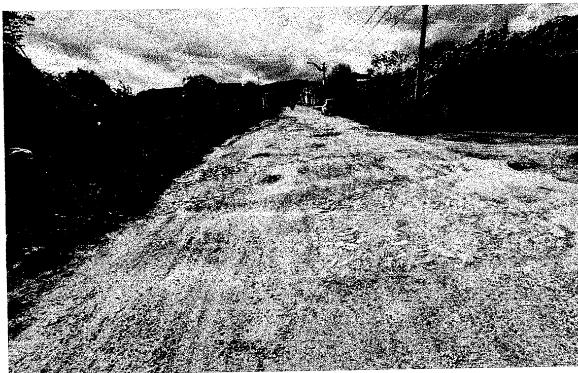
FIGURA 08: RECOMPOSIÇÃO DA PAVIMENTAÇÃO ASFÁLTICA
