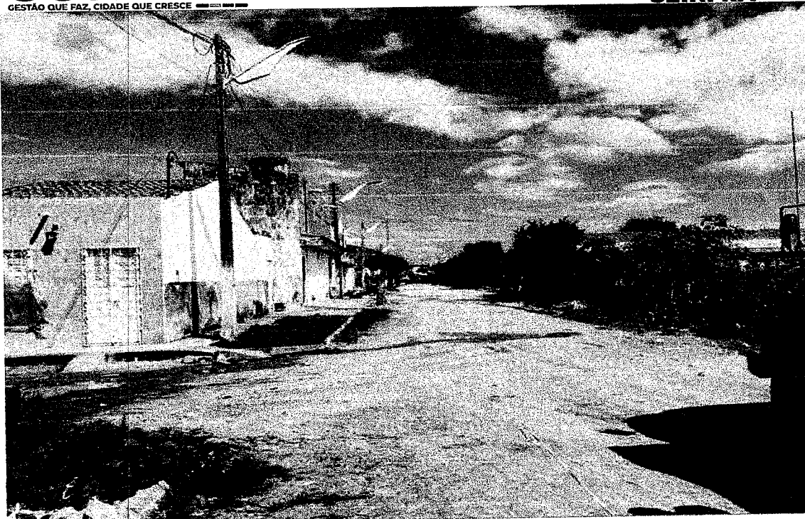
FIGURA 15: RECOMPOSIÇÃO DA PAVIMENTAÇÃO ASFÁLTICA
