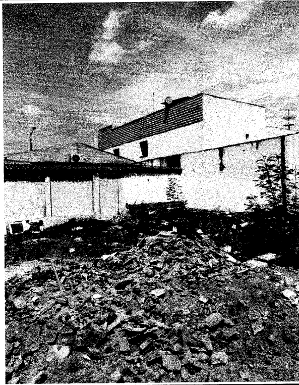
Foto 05 - Vista onde sera construido auditorio e sala de formacao
