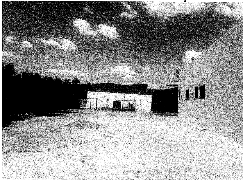
FIGURA 03: LOCAL DA AMPLIAÇÃO
