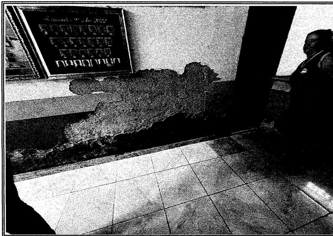
Foto 06- Vista do local que sera feito reboco
