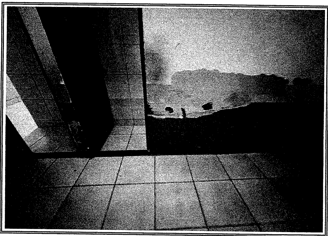
Foto 04- Vista instalacao piso industrial
