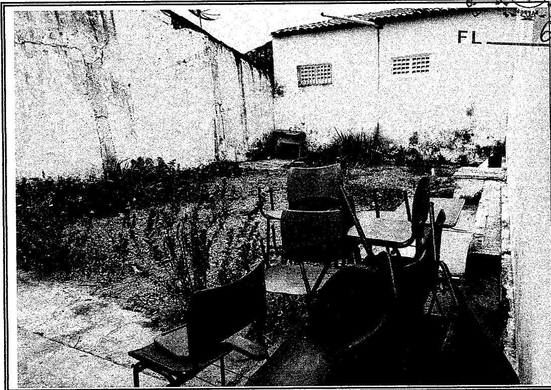
Foto 11 - Vista do local que sera substituida combogos por janela de vidro
