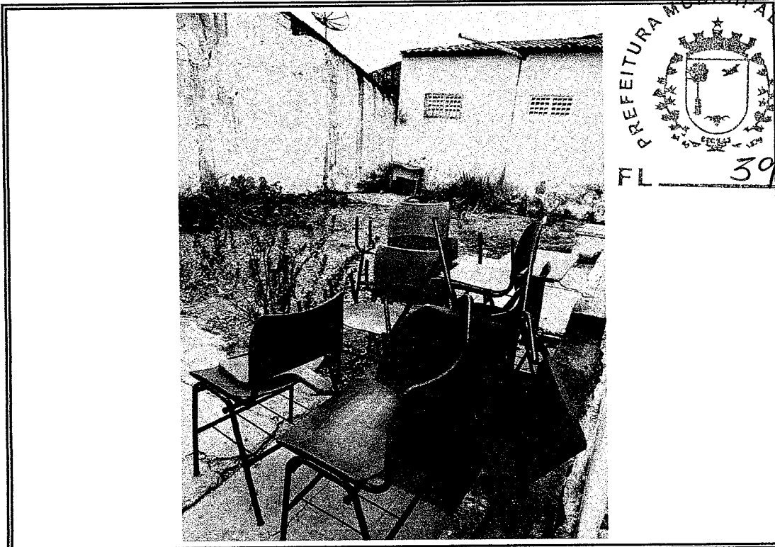
Foto 01 - Vista onde sera ampliado sala de aula
