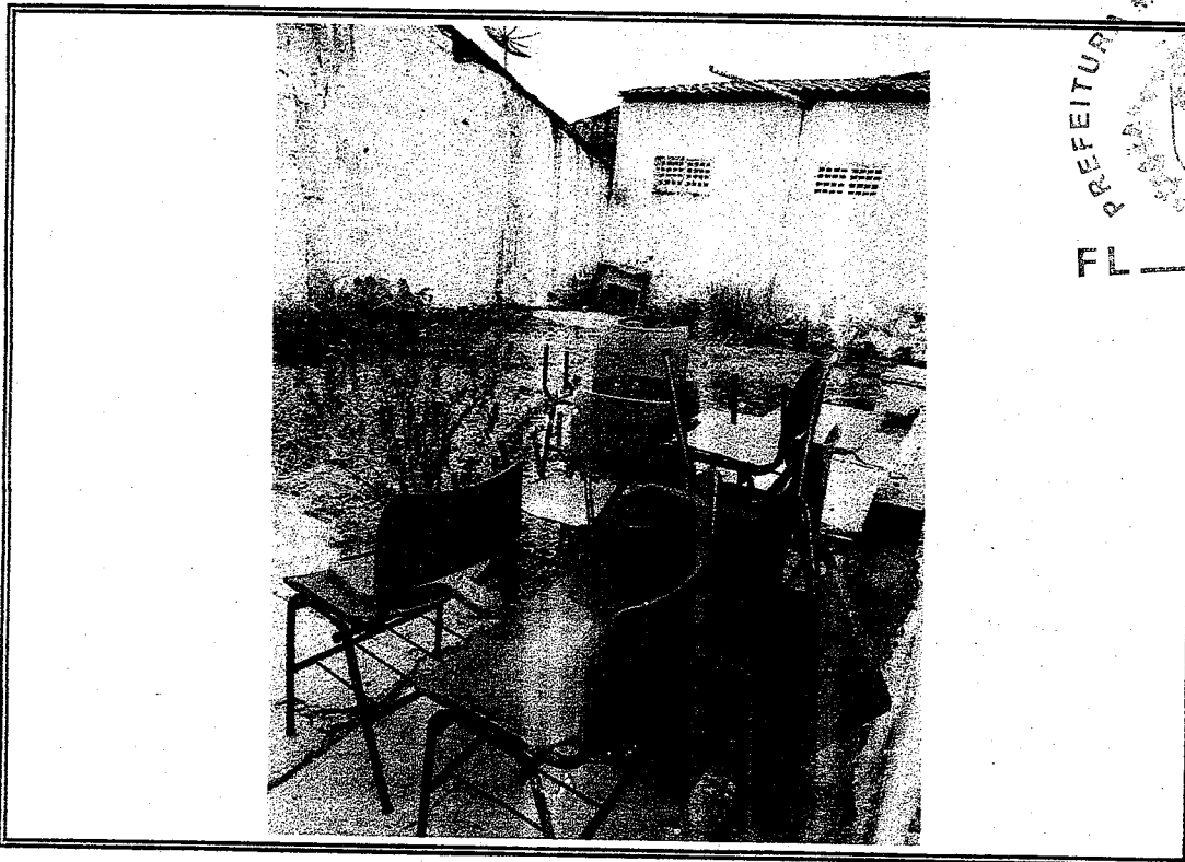
Foto 01 - Vista onde sera ampliado sala de aula
