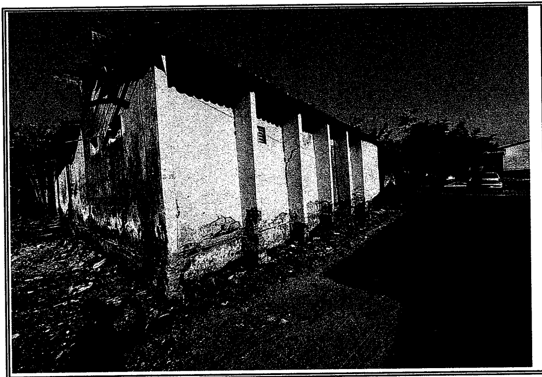
Foto 04-Vista telhado todo danificado
