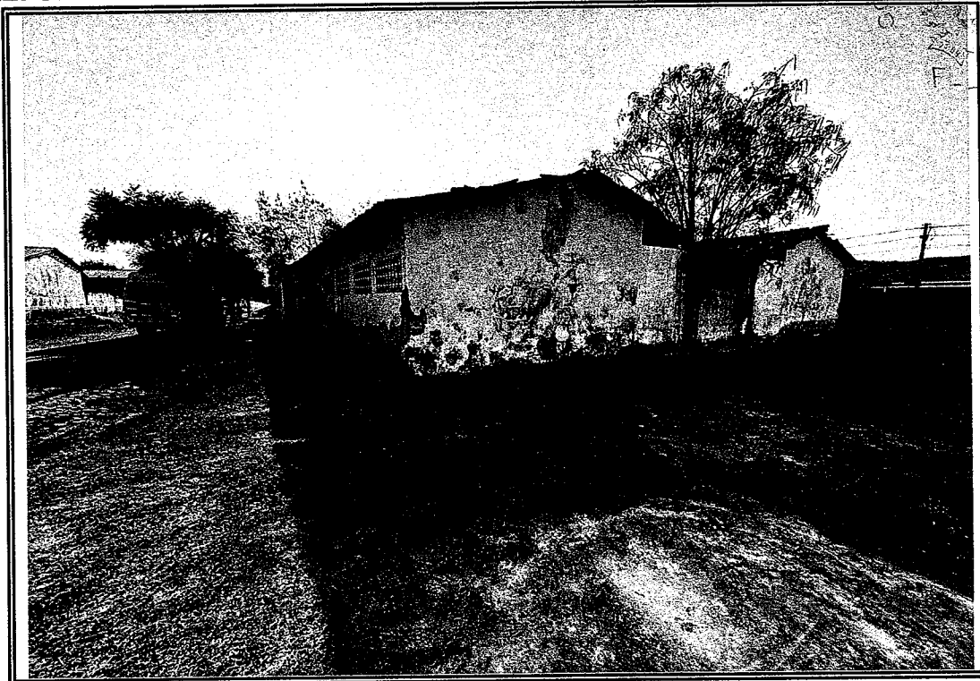
Foto 11 - Vista dos fundos do predio
