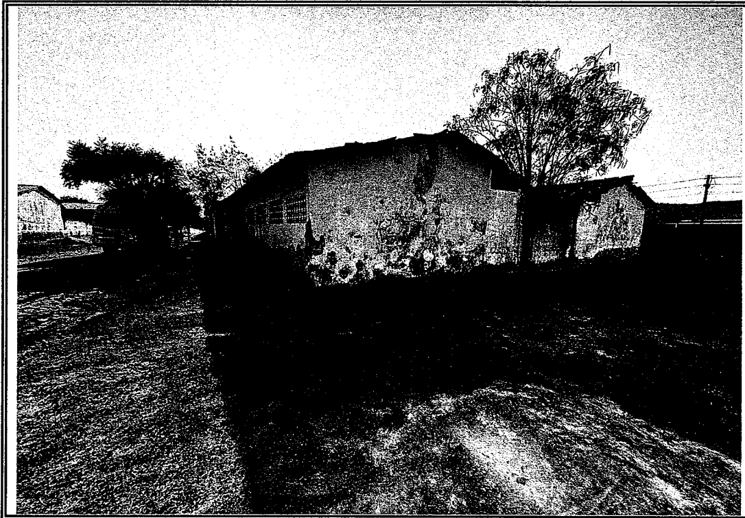
Foto 11 - Vista dos fundos do predio
