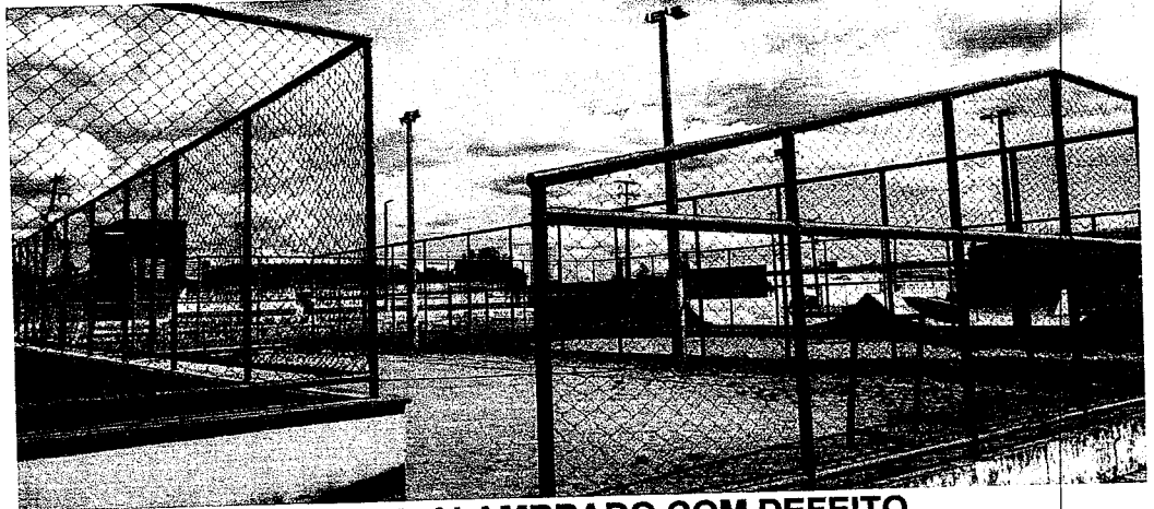
FIGURA 55: ALAMBRADO COM DEFEITO
