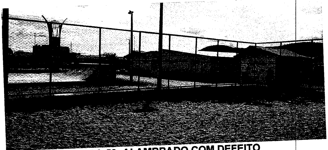
FIGURA 52: ALAMBRADO COM DEFEITO
