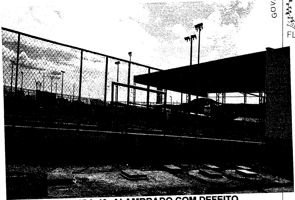
FIGURA 49: ALAMBRADO COM DEFEITO
