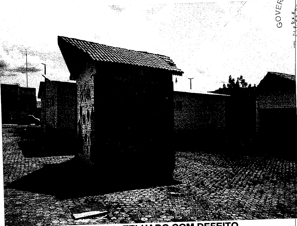
FIGURA 09: TELHADO COM DEFEITO
