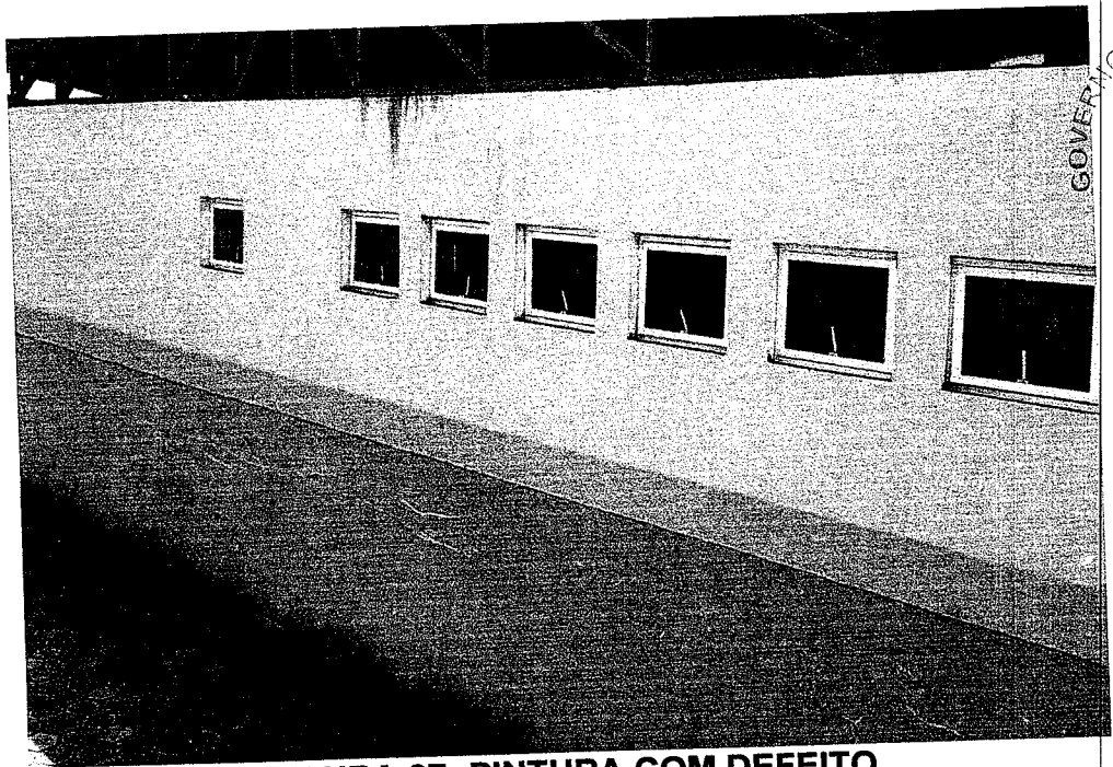
FIGURA 07: PINTURA COM DEFEITO
