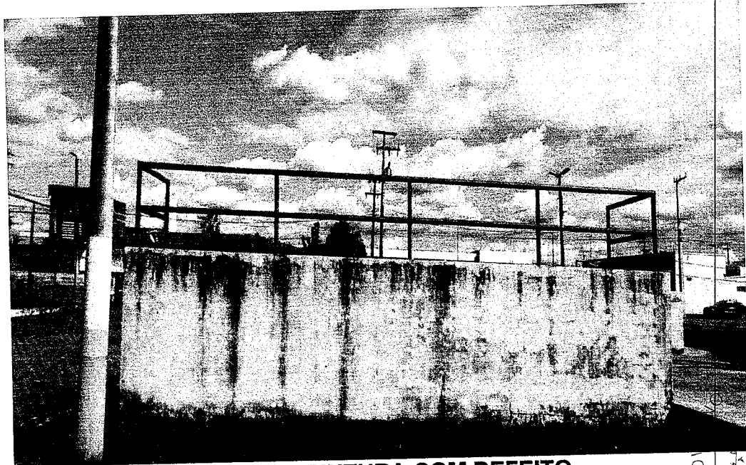
FIGURA 15: PINTURA COM DEFEITO
