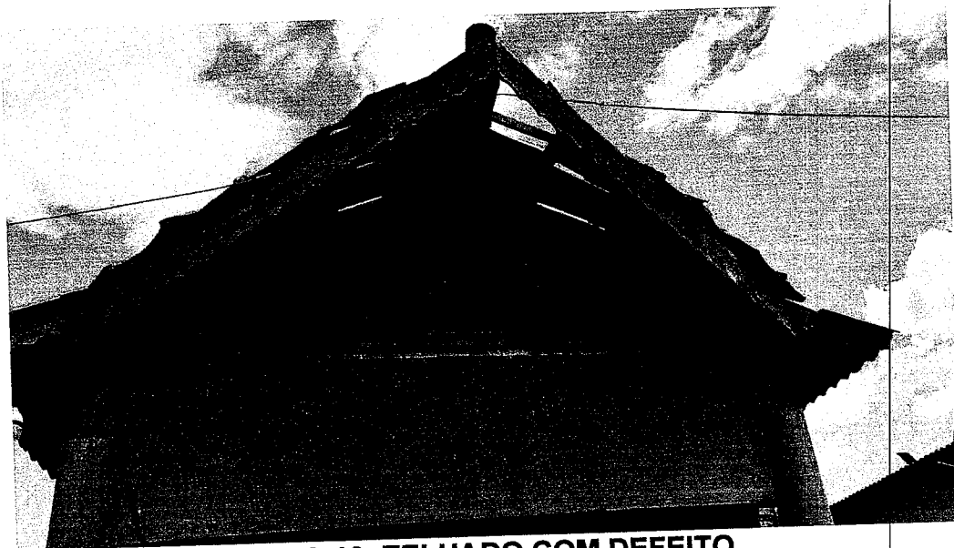
FIGURA 10: TELHADO COM DEFEITO
