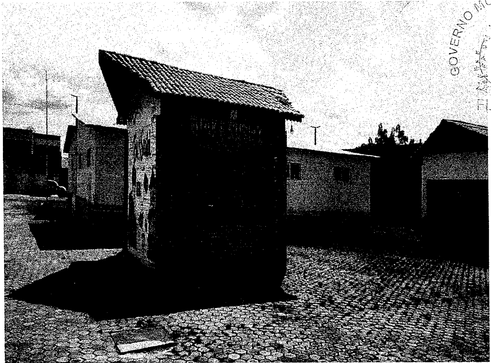
FIGURA 09: TELHADO COM DEFEITO
