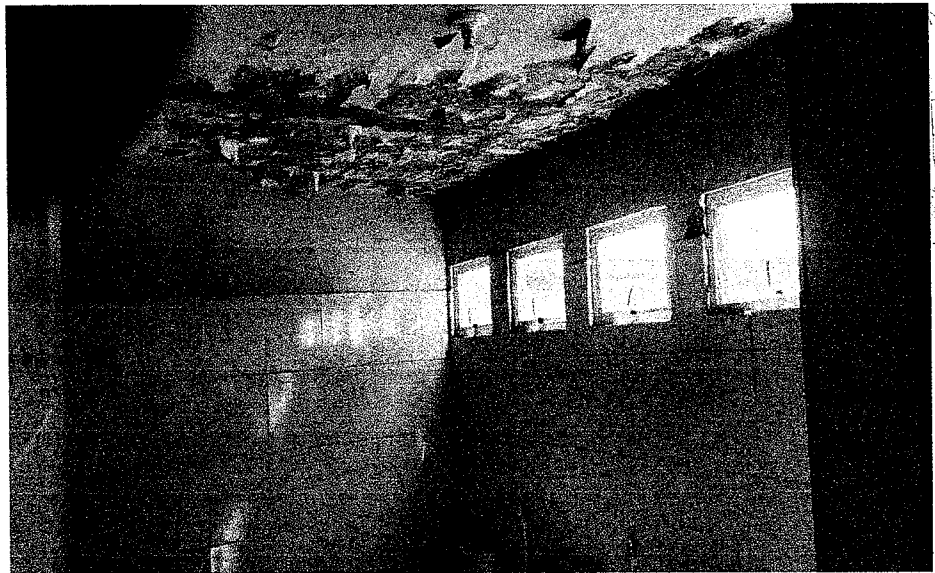
FIGURA 37: REBOCO E PINTURA DO FORRO COM DEFEITO
