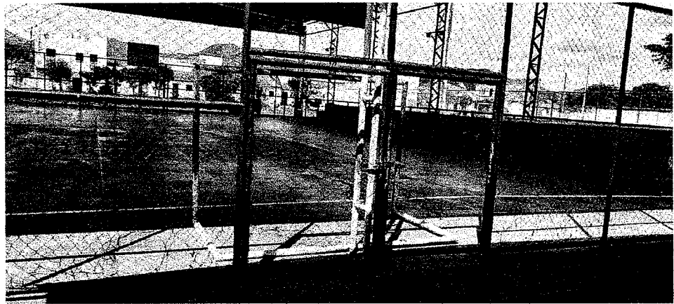
FIGURA 59: ALAMBRADO COM DEFEITO
