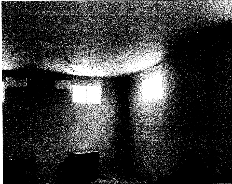
FIGURA 17: REBOCO E PINTURA DO FORRO COM DEFEITO
