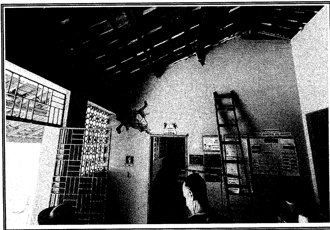
Foto 02- Vista do local que sera retelhado
