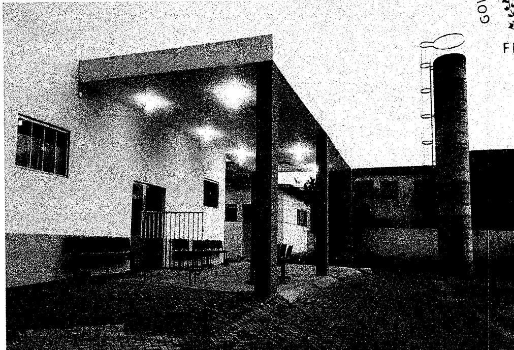
FIGURA 02: LOCAL DA AMPLIAÇÃO
