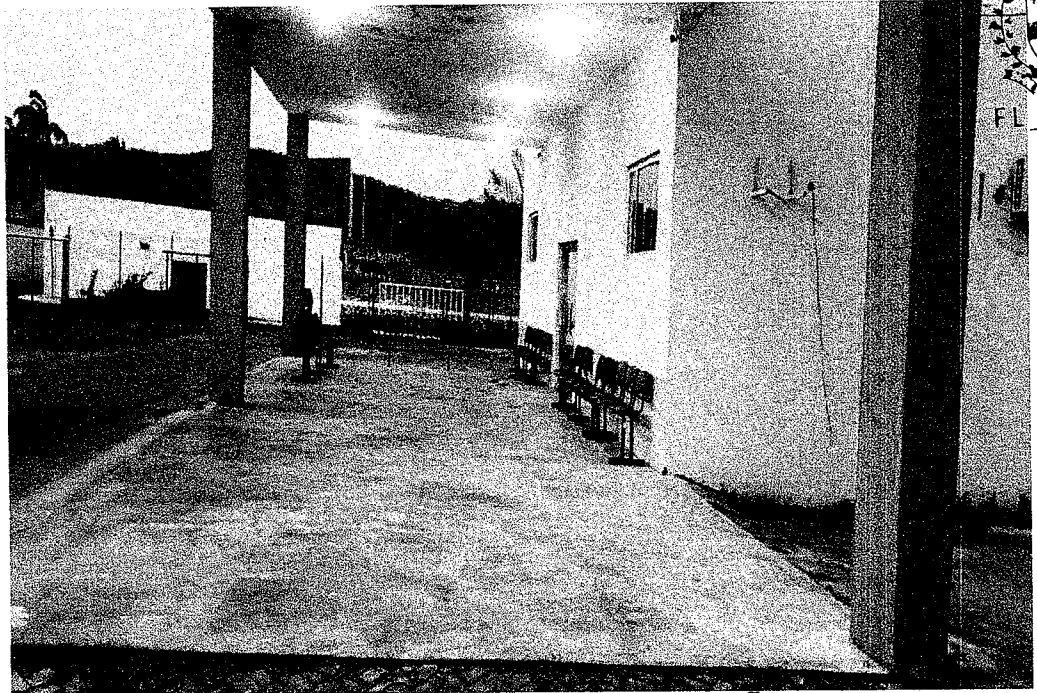
FIGURA 04: LOCAL DA AMPLIAÇÃO
