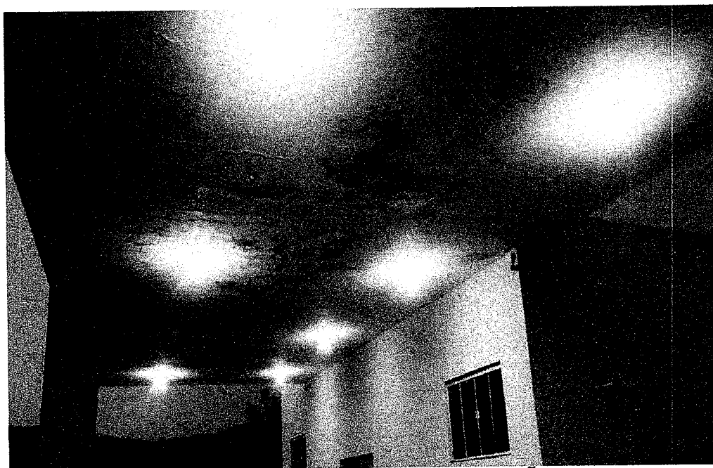
FIGURA 01: LOCAL DA AMPLIAÇÃO
