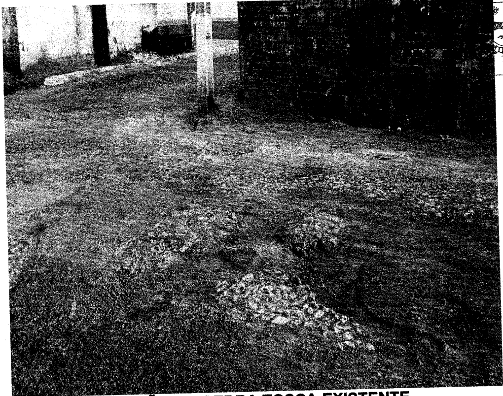
FIGURA 02: PAVIMENTAÇÃO EM PEDRA TOSCA EXISTENTE
