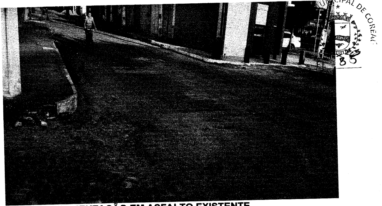
FIGURA 10: PAVIMENTAÇÃO EM ASFALTO EXISTENTE
