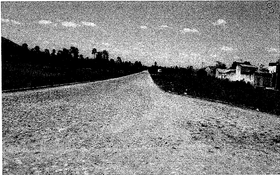
FIGURA 03: PAVIMENTAÇÃO DA AVENIDA ALTO ALEGRE ONDE SERÃO EXECUTADOS OS CALÇADÕES
