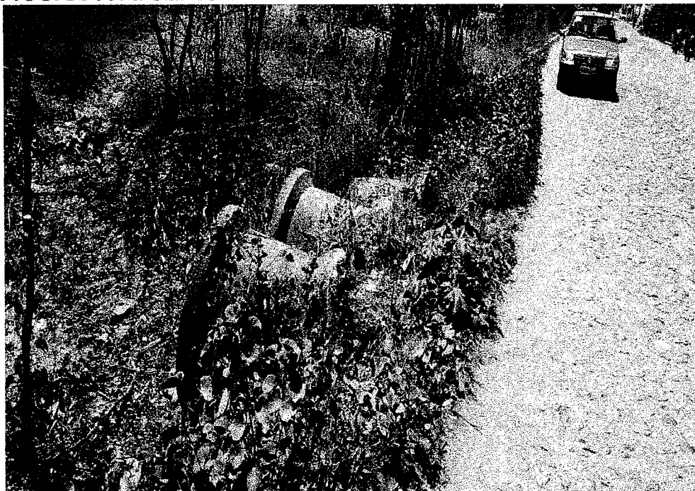
FIGURA 06: BUEIRO DA AVENIDA ALTO ALEGRE COM DEFEITO
