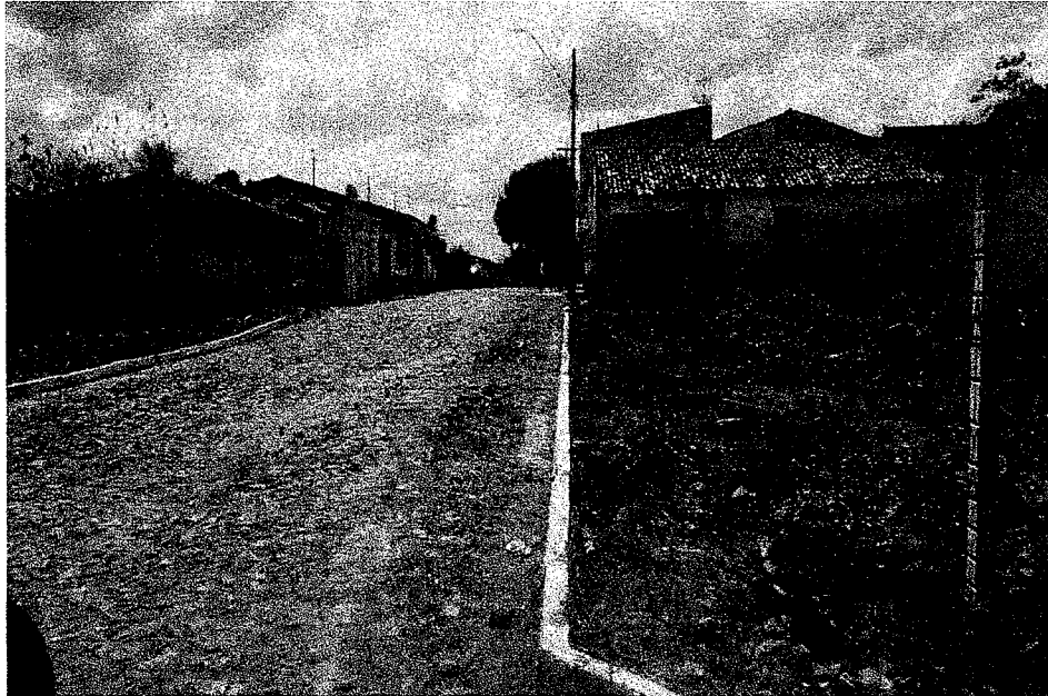
FIGURA 15: PAVIMENTAÇÃO AVENIDA ALTO ALEGRE COM DEFEITO
