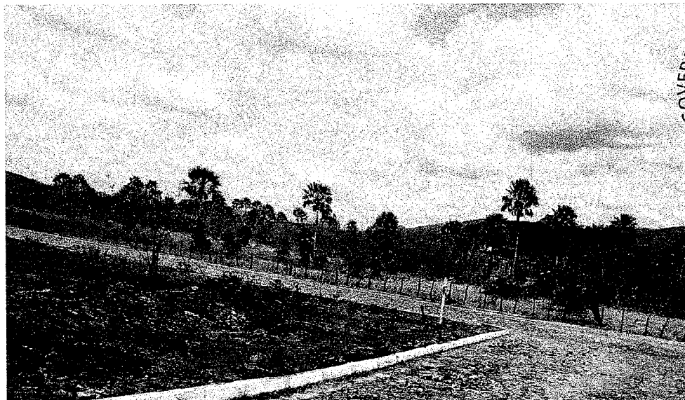
FIGURA 16: PAVIMENTAÇÃO AVENIDA ALTO ALEGRE COM DEFEITO
