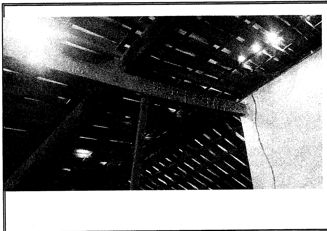
Foto 04-Vista do local onde será recuperado o madeiramento com linhas, caibros e ripas.
