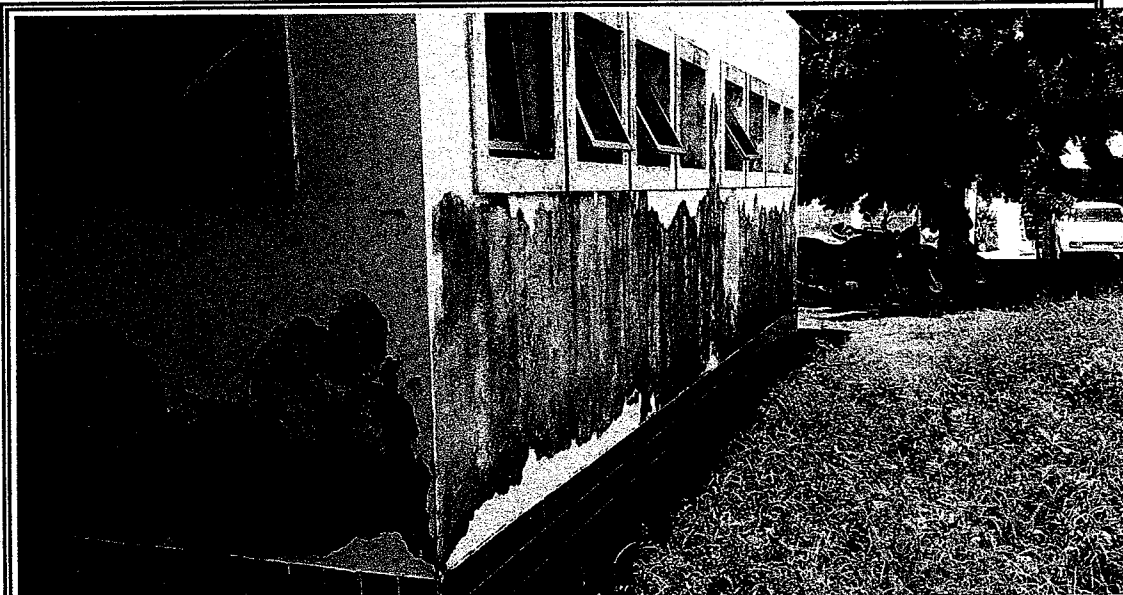
Foto 01 - No local deverá receber revestimento no forro e novas instalações elétricas conforme normas.
