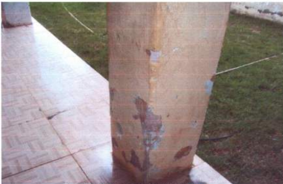
FIGURA 09: REBOCO COM DEFEITO
