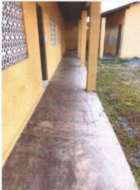
FIGURA 08: TELHADO COM DEFEITO E UNIDADE
