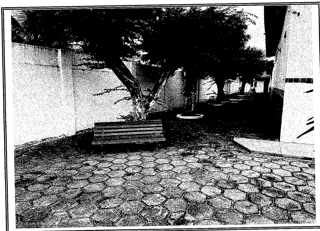
Foto 02- Vista do local que sera construido refeitorio
